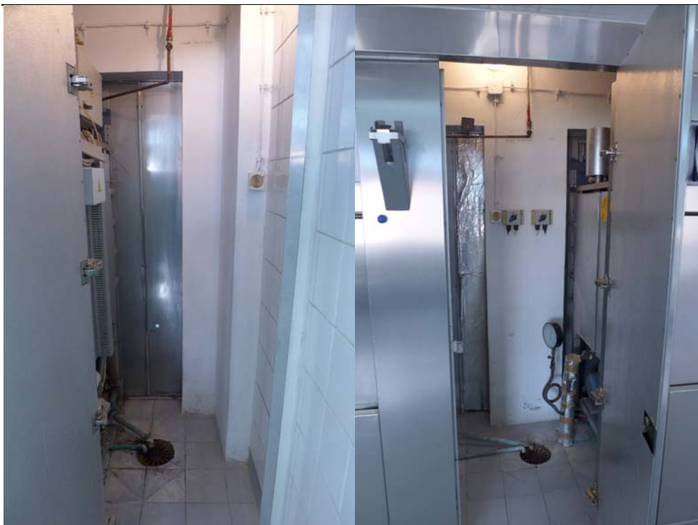
Zdjęcie 5 – wpust podłogowy w prawej przestrzeni technicznej
